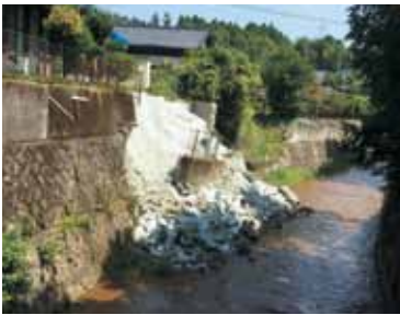
上井手の仮修復の現場
