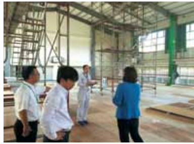
北小体育館の修復状況
