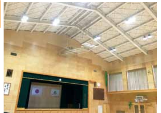
中部小体育館天井耐震化工事完工状況
