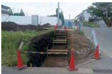
光の森 歩道工事
