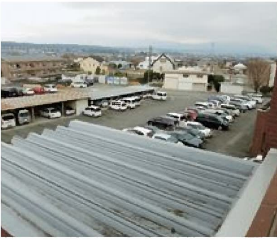
防災センター建設予定地
