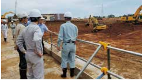
最終処分場埋立地工事現場風景
