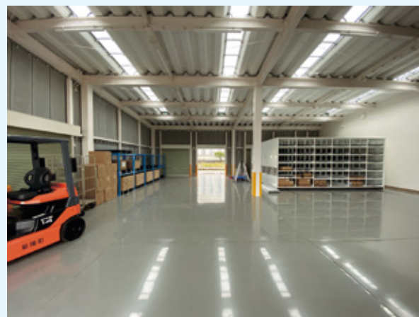
備蓄倉庫の内部
