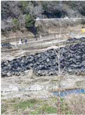
白川護岸工事の光景
