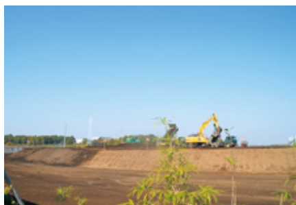
整備中の第二原水工業団地
