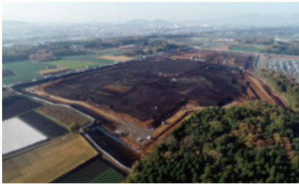
整備中の第二原水工業団地
