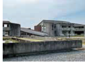
被災したプールから見た校舎
