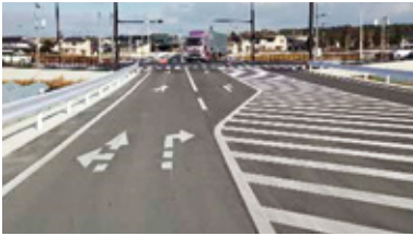
増設された右折レーン
