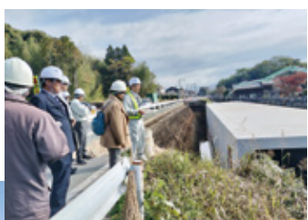
「空港線堀川またぎ現場」
