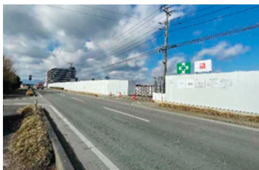
造成工事が進むJASM第2工場用地
