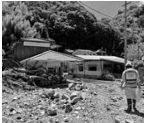
土砂により家屋の半分が流されている
