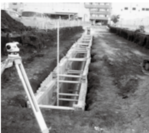
汚水管工事の状況
