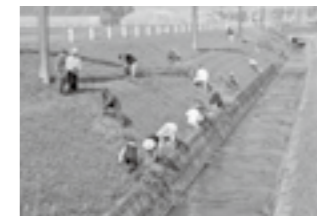
水路沿いの除草作業
