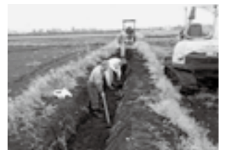
水路の泥上げ作業
