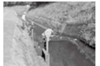
水路や農道に設置された施設の点検
