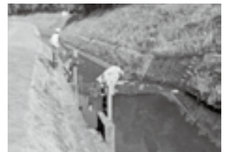
水路や農道に設置された施設の点検
