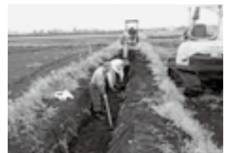
水路の泥上げ作業
