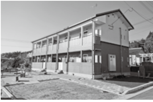
古閑原団地外観
