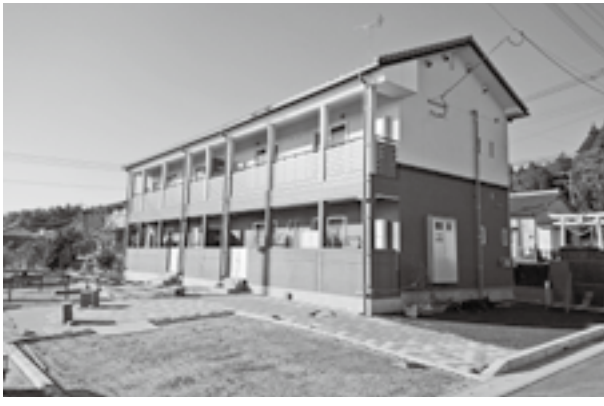
古閑原団地外観
