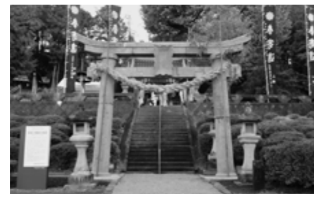
修復された町指定文化財「若宮八幡宮の鳥居」
