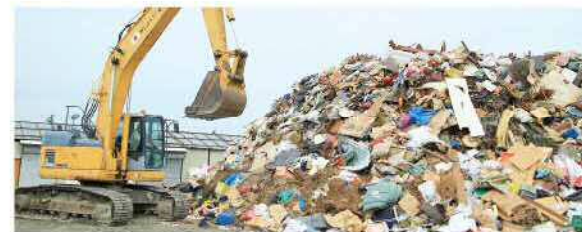
災害ごみの仕分けを行った菊陽土木建設業協会(現:菊陽建設業協会)
