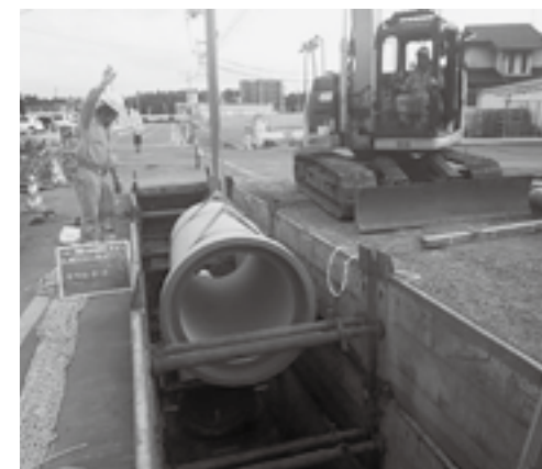
雨水管整備の状況
