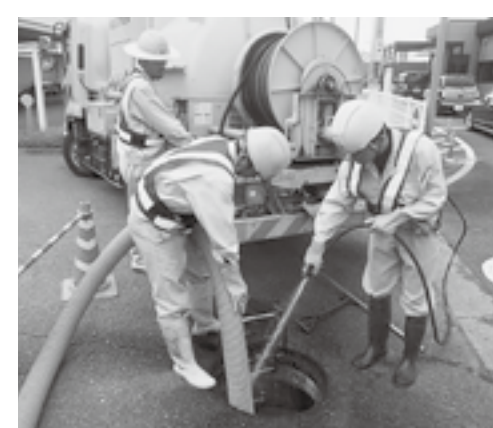
管路清掃の状況
