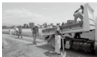
農道の砂利敷き作業
