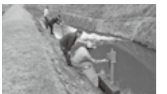
水路の施設の点検
