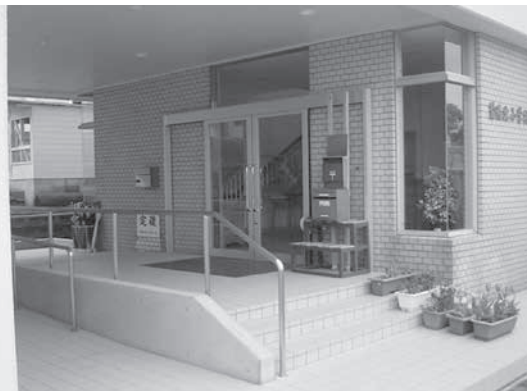
手すりやスロープが設置された改修後の玄関
