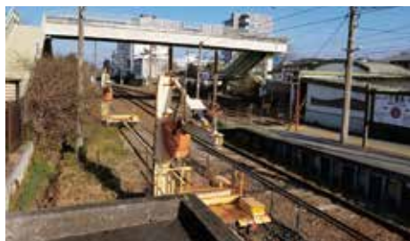
三里木駅線路部
