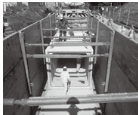
雨水管整備の状況
