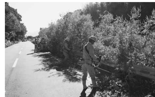
除草作業中の様子
