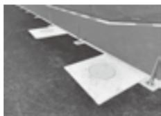
災害時の飲料水として、60<sup>リットル</sup>の耐震性貯水槽を整備しています。1人1日3<sup>リットル</sup>として、4千人分の5日分を備蓄しています。
