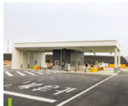
ごみの搬入時に重さを測る計量器。屋根には太陽光パネルも設置されている
