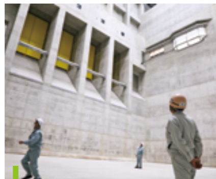
空のごみピット内。ごみが搬入される前の貴重な光景で、黄色の扉からピット内にごみが入られる
