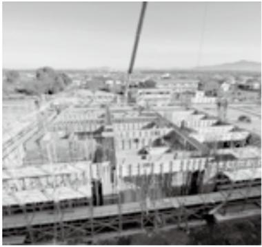
これらが終わったら、上からコンクリートを流し込んで、1階柱・壁部分と天井・2階床部分を一体的に作ります。2階部分も同様に作っていきます。
