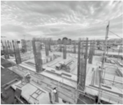
1階天井の型枠設置と配筋も行い、それが2階床部分になります。
