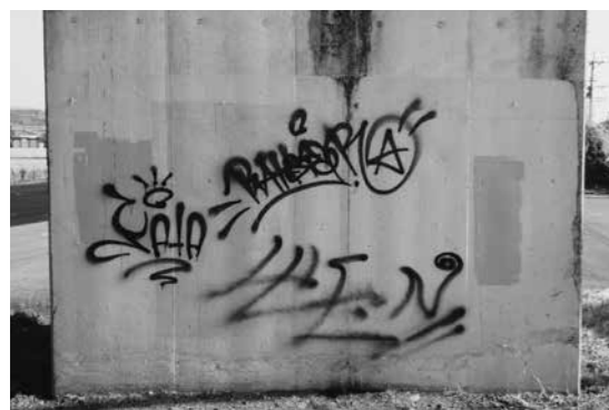
落書きされた橋脚
