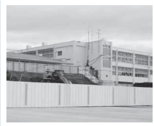
3月完成に向け造成工事中
