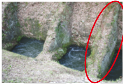
※赤丸の部分を隔壁と呼びます
