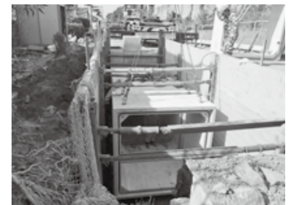
雨水管整備の状況
