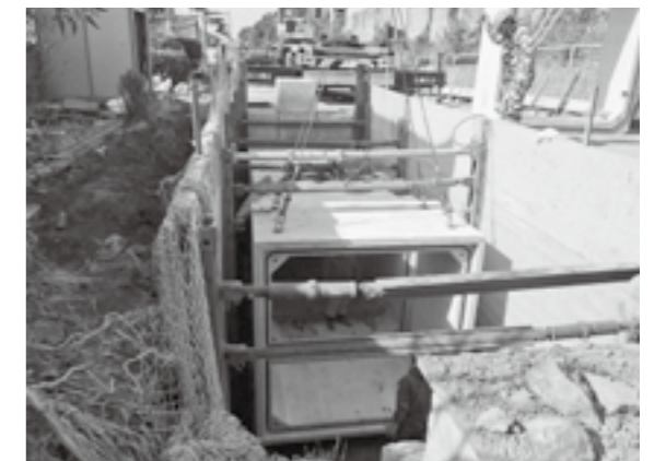
雨水管整備の状況
