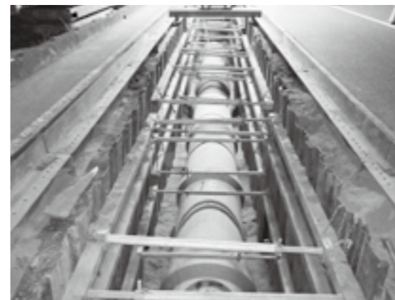
污水管整備の状況
