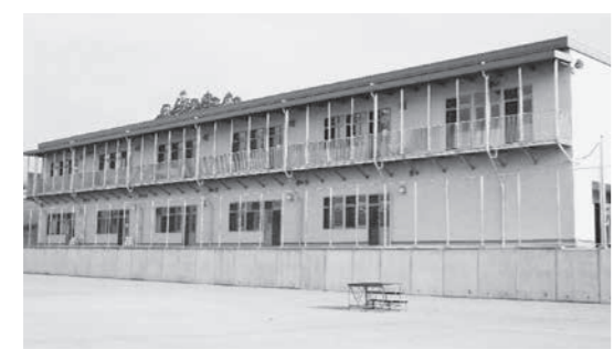
完成した増築校舎
