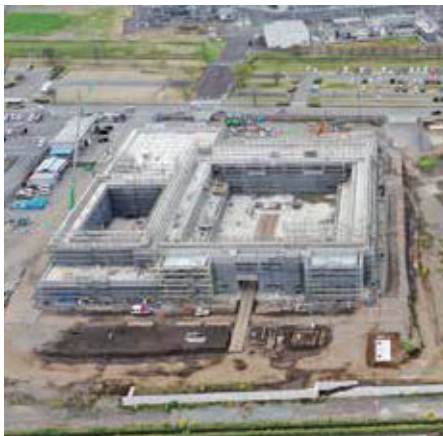
総合体育館建設風景
