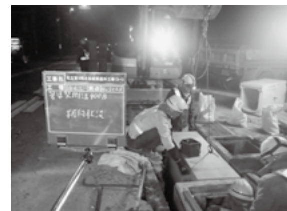
花立地区雨水管整備の状況
