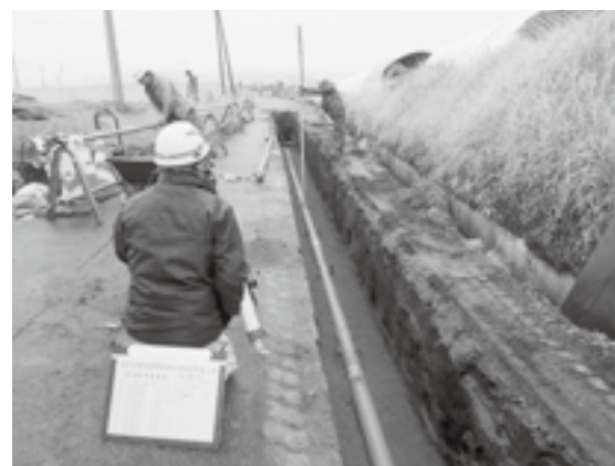
曲手地区污水管整備の状況
