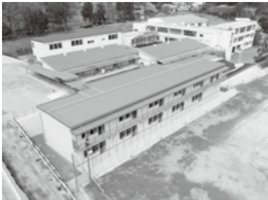
菊陽北小学校増築工事
