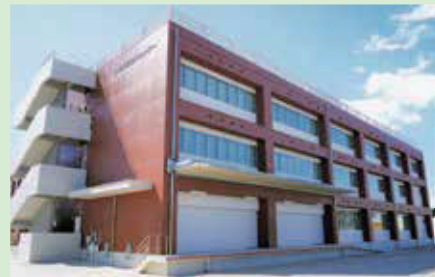
【防災センター】
