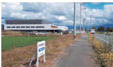
建設中の新総合体育館
