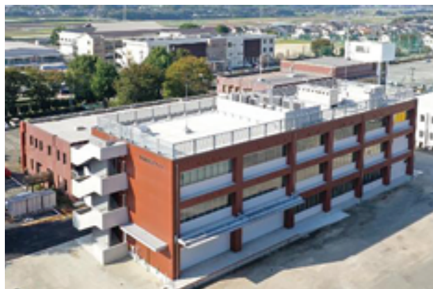
菊陽町役場 防災センター
