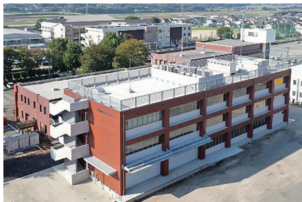
菊陽町役場 防災センター
