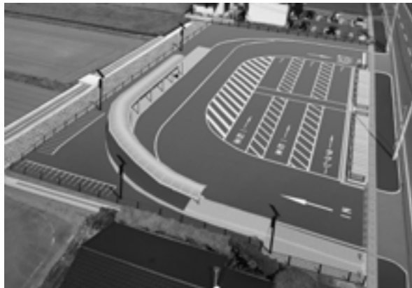
原水駅北口転回広場
