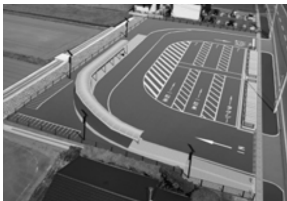
原水駅北口転回広場
