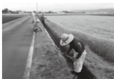
農道側溝の泥上げ、ごみ上げ
