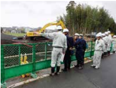
堀川の工事現場
