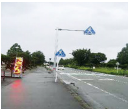
さんふれあ前に設置された大型標識
