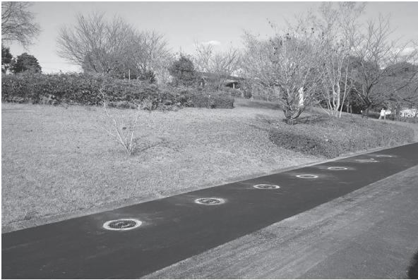
ふれあいの森公園マンホールトイレの設置状況
