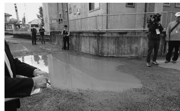
水たまりを解消するために舗装工事を実施予定
