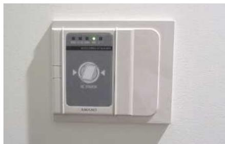
写真 4-7 ICカードや手のひら認証による入退室管理の例
