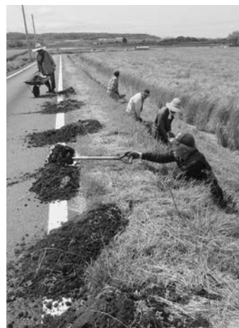
水路・側溝の泥上げ、ごみ上げ
