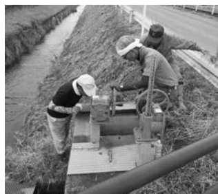
水路施設の点検、管理
