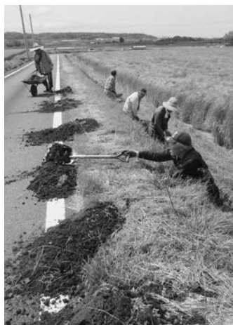
水路・側溝の泥上げ、ごみ上げ
