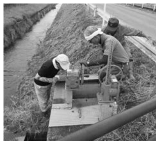
水路施設の点検、管理
