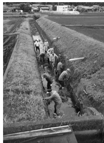
水路の清掃、草取り
