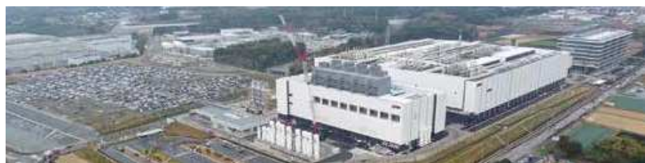
原水工業団地に立地した工場
