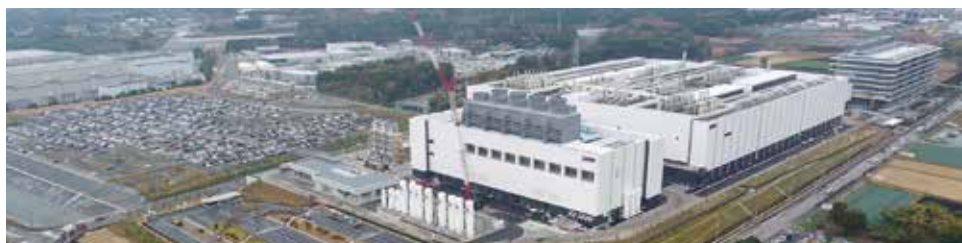
原水工業団地に立地した工場
