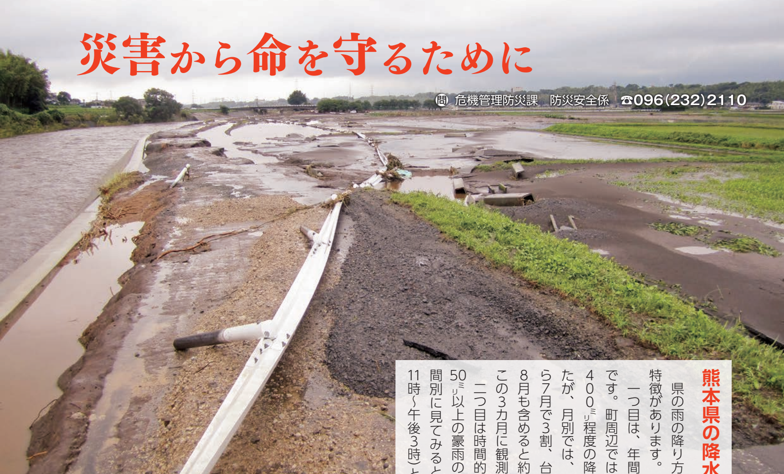
平成24年7月12日 九州北部豪雨 白川の増水でなぎ倒されたガードレール(上津久礼)
