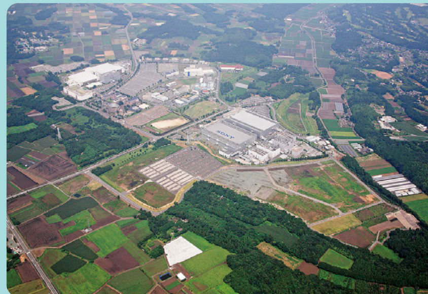
造成工事が完了した原水工業団地
