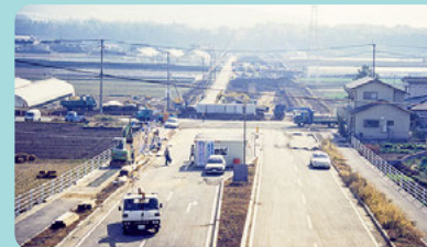
工事が進む菊陽空港線
